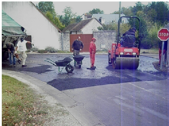
Travaux dans le carrefour de la rue du Vieux Moulin et de la rue de la Borde, à Macé
